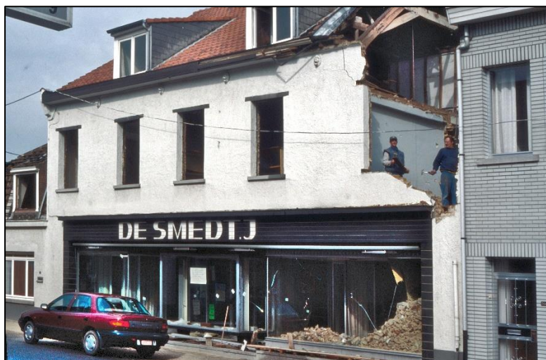
De afbraak van het oude gebouw.
