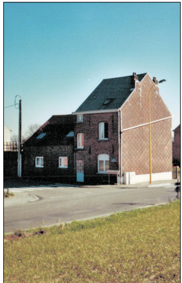
Het huis nr. 81 op de hoek van de Merchtemsesteenweg en de Driesstraat, gezien vanuit de richting van Merchtem – foto 2007.
