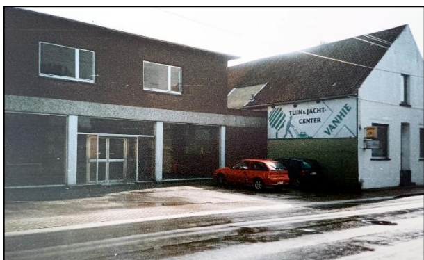
Rechts het huis nr. 71 en links het later bijgebouwde pand nr. 73.
