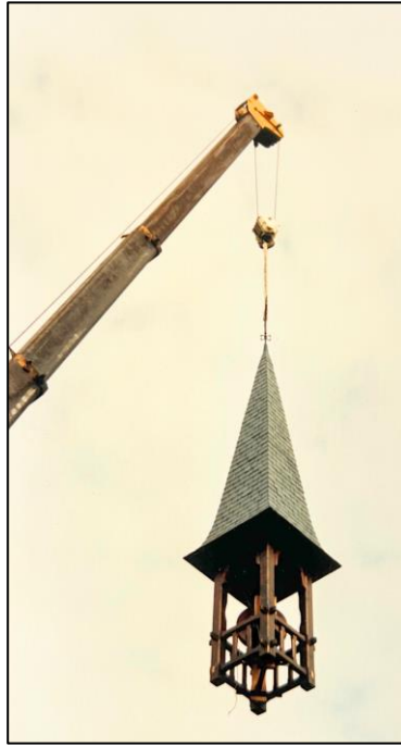
De nieuwe torenspits van de kerk in Westrode en de plaatsing ervan.
