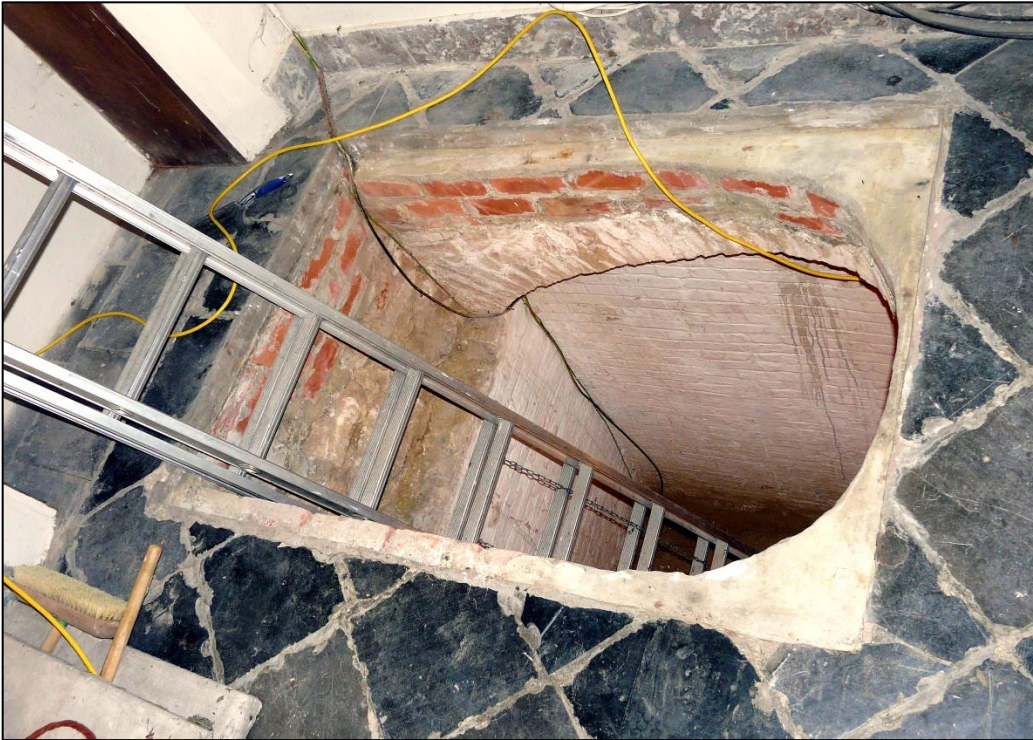
Toegang tot de crypte d'Hoogvorst via de vloer van de sacristie.
