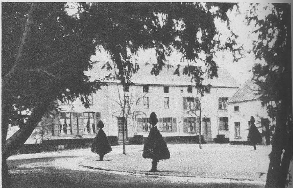
De lusthof « Sans-Souci », in Vlaams-Spaanse bouwtrant, rustig, groots en voornaam. Hier leefde en stierf de moeder van Kardinaal Steyckx. Hier ook kwam dezelfde Kardinaal rusten na zijn drukke bezigheden te Mechelen. Binnen zijn de muren en meubels in dezelfde rustieke stijl gehouden. Een kenner zal zelfs de prachtige koperen deurklinken bewonderen.
